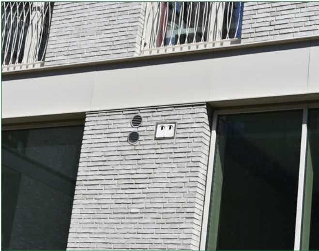
Eingebaute Nisthilfen in der Fassade
