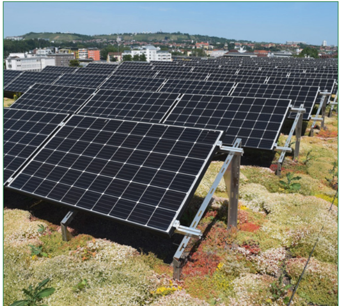
Solargründach: Kombination aus Dachbegrünung und Photovoltaik
