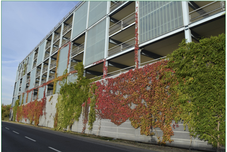
Bodengebundene Fassadenbegrünung mit Selbstklimmer (Wilder Wein)
