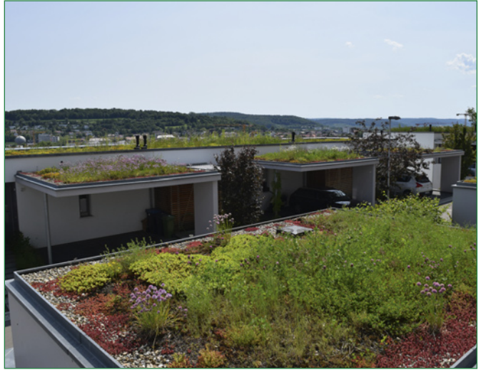
Extensive Begrünung auf einem Flachdach
