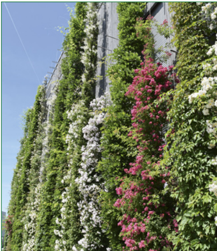
Sommerlicher Blühaspekt einer Fassadenbegrünung
