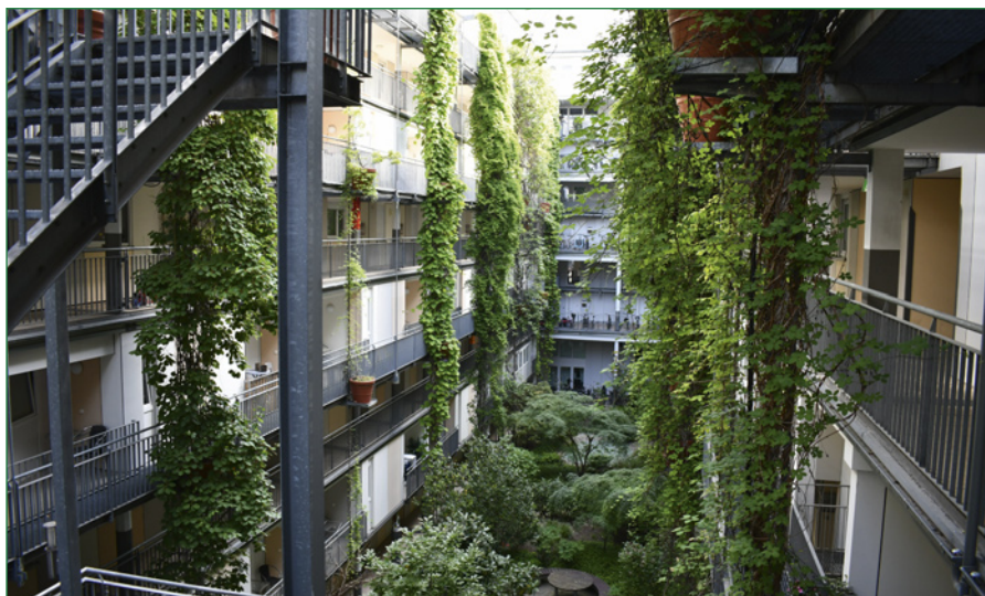
Fassadenbegrünung mit Gerüstkletterpflanzen aus Pflanztöpfen im Innenhof
