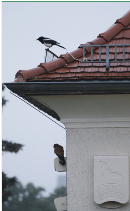
Fledermauskasten an der Fassade
