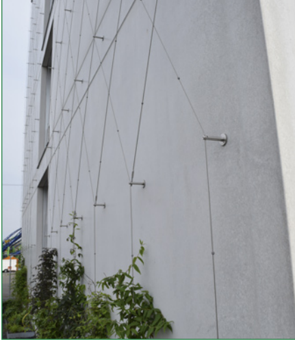
Verankerung einer Kletterhilfe für Gerüstkletterpflanzen an der Fassade
