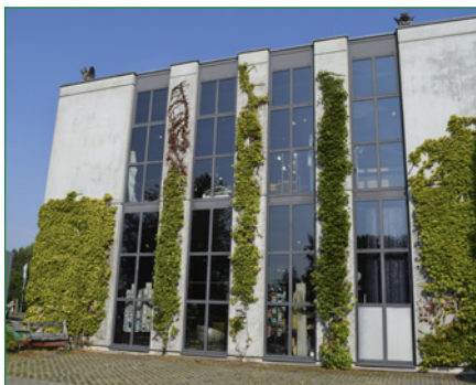
Fassadenbegrünung mit Wildem Wein (Selbstklimmer) an fugenfreier Betonfassade
