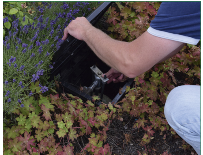
Kontrollschacht, Be- und Entwässerung prüfen
