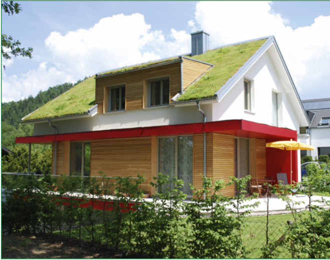
Extensive Begrünung auf einem Schrägdach
