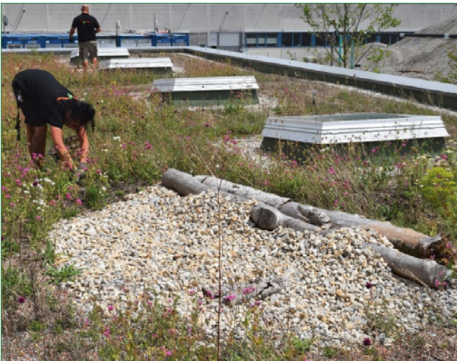
Entfernen von unerwünschtem Aufwuchs auf dem Dach
