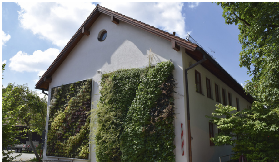
Wandgebundene Fassadenbegrünung mit modularem System
