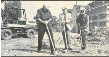
Spatenstich für das Stadtforum Bad Saulgau Foto: Tbg Bad Saulgau mbH, Archiv
