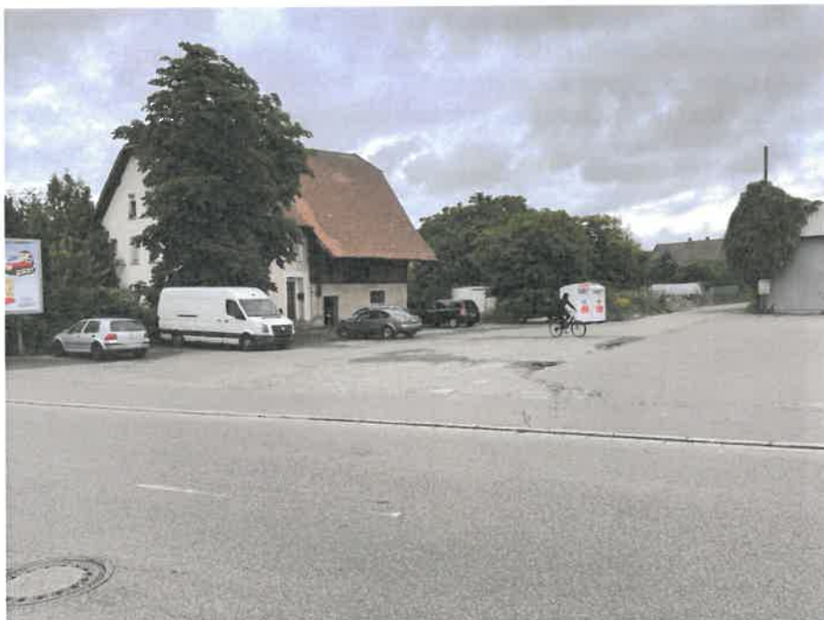
Wohnhaus mit Ökonomieteil, Garten und Hofffläche
