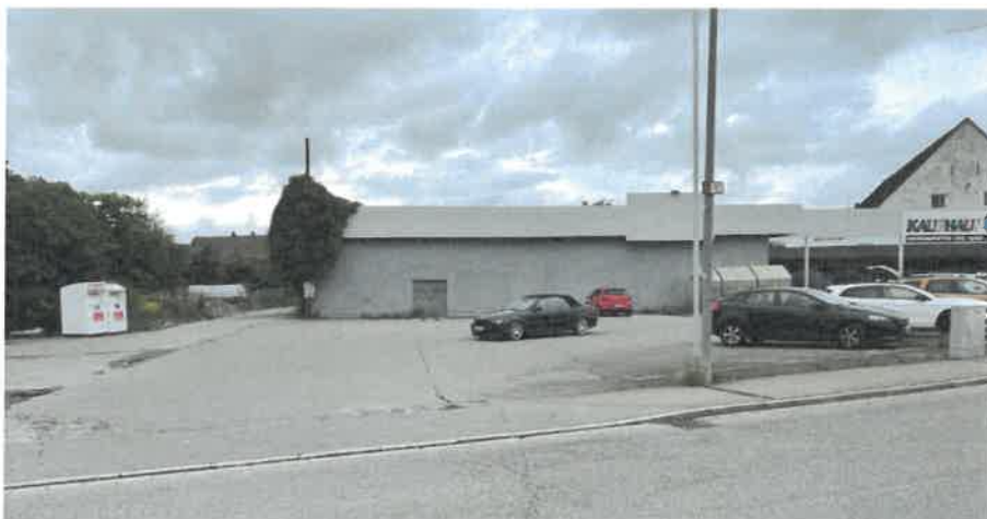
Blick von der Platzstraße auf das Gewerbeareal, ganz rechts die als Einkaufsmarkt genutzte Fläche mit vorgelagerten Parkplätzen
