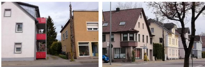
Abb. 9 und 10 Kaiserstraße nordöstlich Straßenseite
