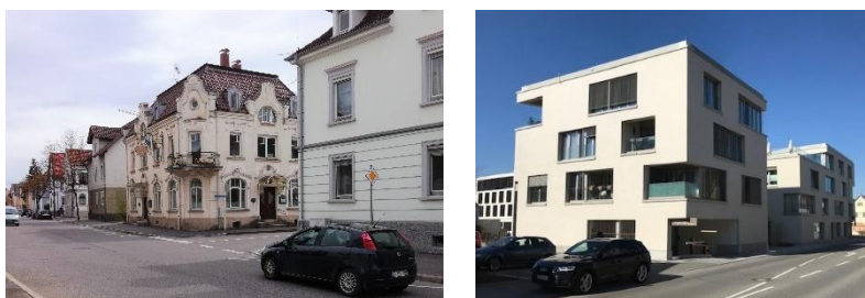
Abb. 11 und 12 Kaiserstraße südwestliche Straßenseite
