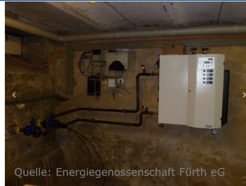
Wärmetauscher Hausübergabestation
